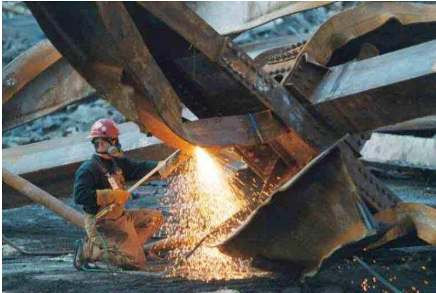
Trennarbeiten beim Aufräumen. Die Verbindungsnieten haben gehalten.
